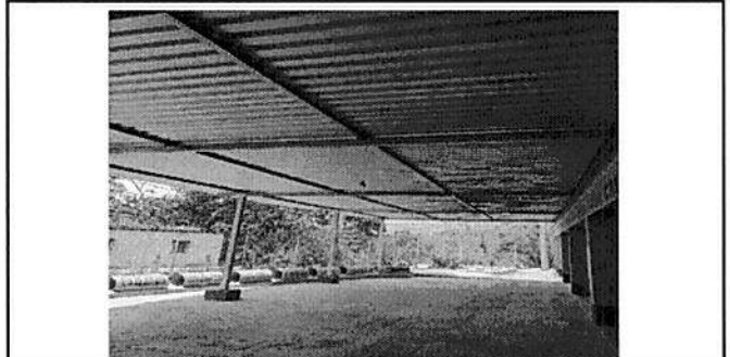
Foto: Pertenece a modulo 3 instalacion de cableado electrico y suministros
