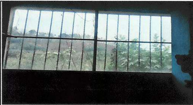
Foto 3: Fabricación de ventanas corredizas de aula 1 y aula 2
