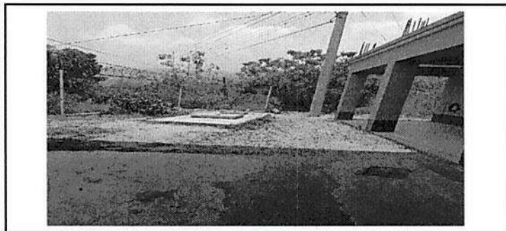
Foto: mejoramiento y ampliacion de galera
