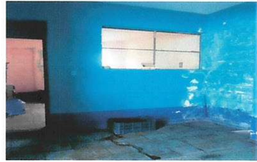
Foto 2: fabricación de una pila de concreto levantado de pared de block acabado con repello y sernido fabricacion de balcon tipo caseta
