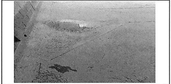
Foto: area de perforacion para instalacion de tuberia pvc
