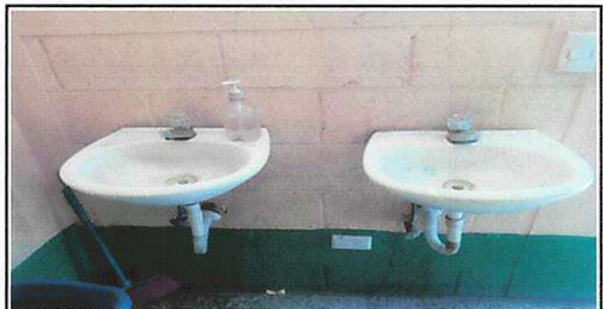
Foto 6: reparación de lavamanos
